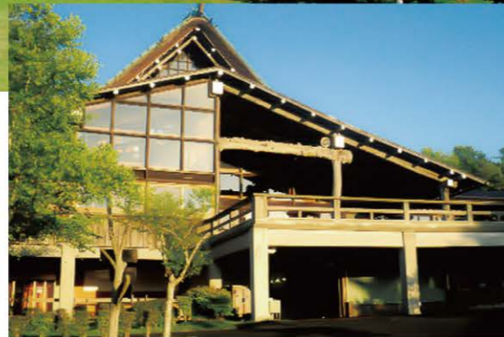
合掌造りのクラブハウスから渡り廊下で結ばれた趣のあるロッジ。
